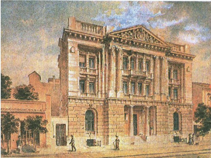
Αθήνα, Νεοκλασικό κτίριο
